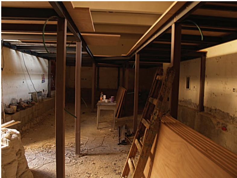
Lavori in corso per la nuova biblioteca
