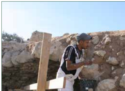
Lavori di restauro in corso
