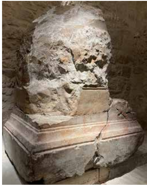
La base attica con piedistallo dopo la pulitura, il restauro e il consolidamento (maggio 2023)
