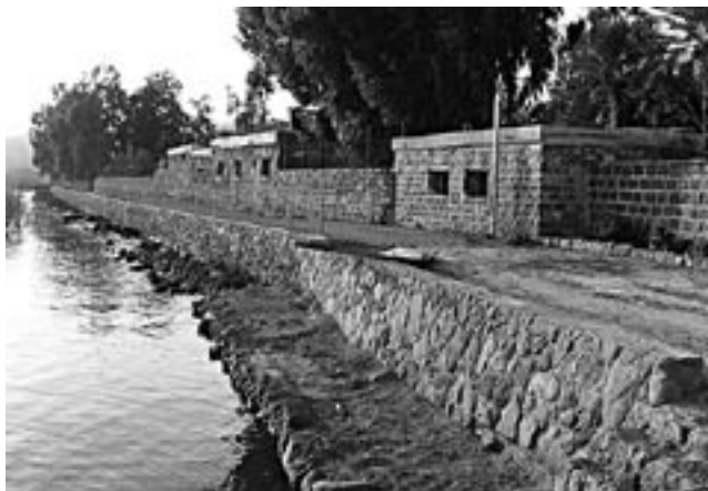
Sopra: La riva del lago dopo i lavori.
